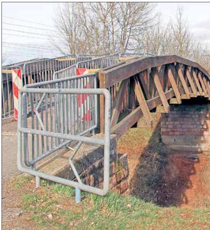
Die Brücke des Fuß- und Radweges über die Bahnlinie zwischen Ramstein und Miesenbach wird erneuert (Foto: Verbandsgemeinde).
